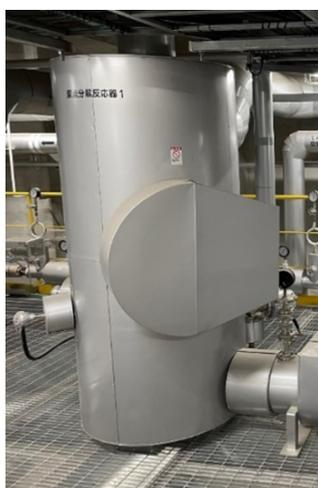
図 8 尿素分解反応器の外観
