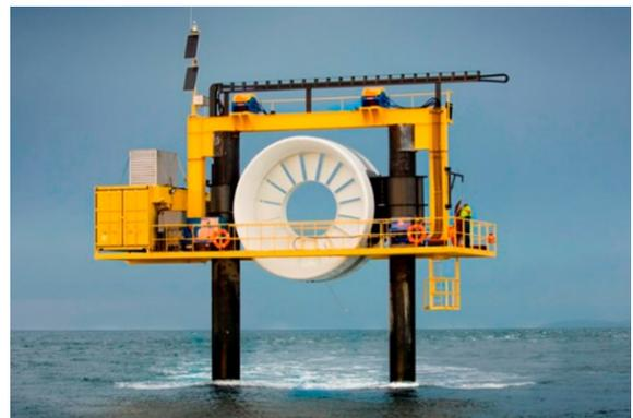
Fig. 12 OpenHydro open centre turbine<sup>10)</sup>.
