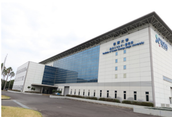
図6 佐賀大学海洋エネルギー研究所
