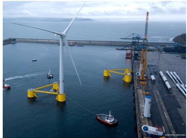
図 16 WindFloat Atlantic の風車設置施工の様子<sup>11)</sup>
