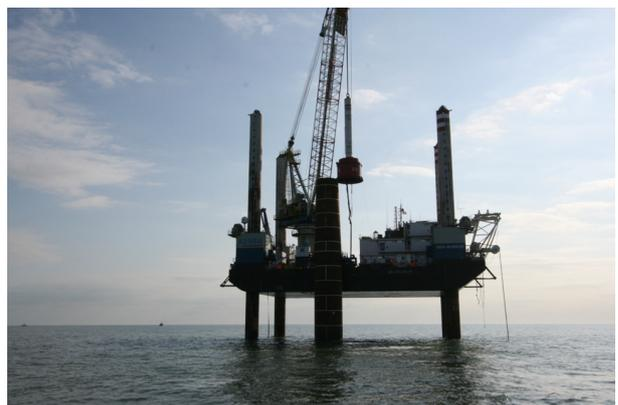
図6 SEP台船 Sea Worker でのモノパイル打設状況<sup>3)</sup>
