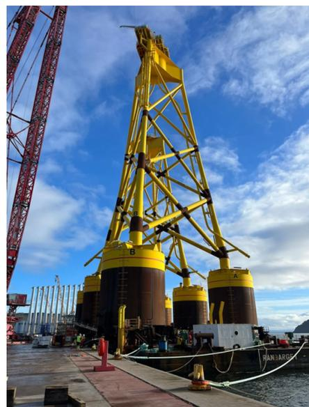
図10 サクシヨンバケット基礎を有する3本脚ジャケット<sup>6)</sup>
