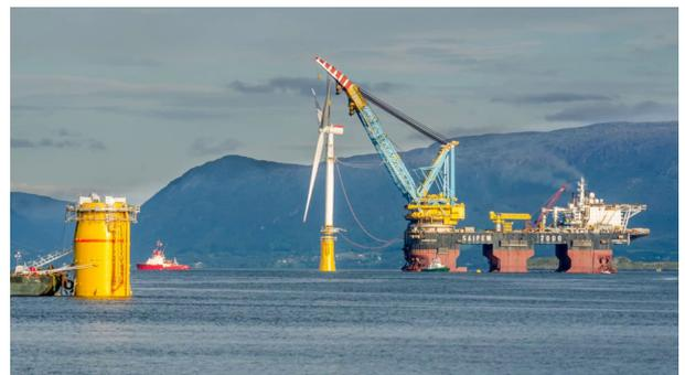
図13 Hywind Scotlandの風車設置施工の様子<sup>8)</sup>
