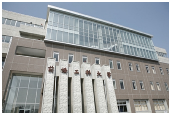
写真1 前橋工科大学1号館
