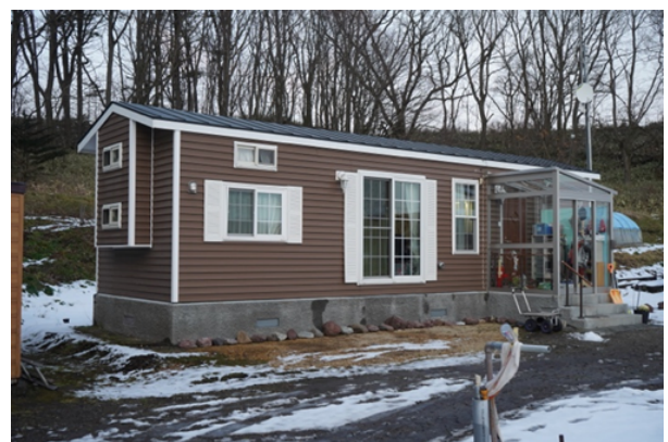
写真9 ABI-A, 布基礎に緊結された ABI-3
