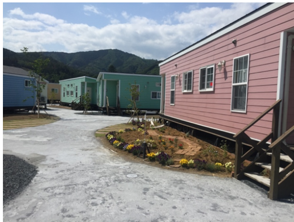
写真2 高上げ工事後移設されたエル・ファロ
