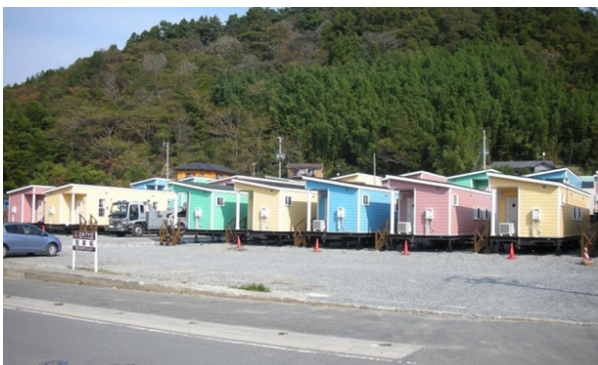
写真1 女川町に震災後に設置された宿泊施設
