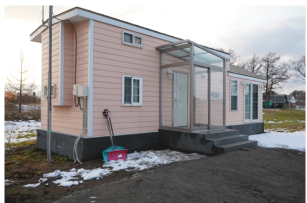
写真10 ABI-B, 布基礎に緊結された ABI-4
