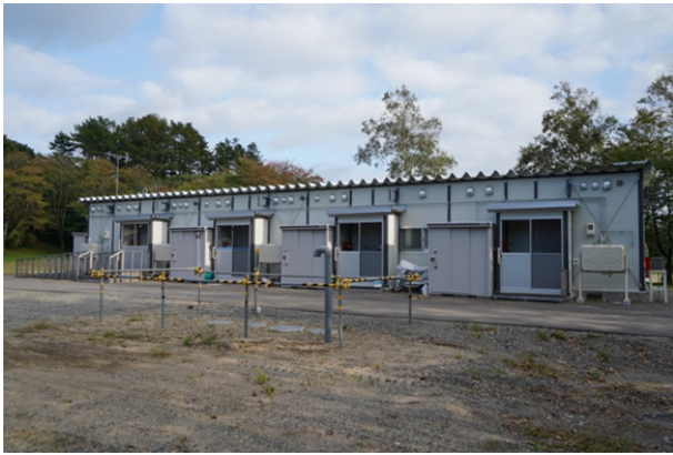
写真3 プレファブ型の応急仮設住宅
