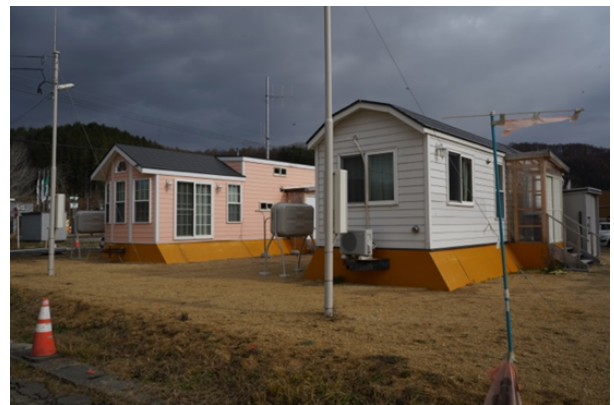
写真5 ATS-3, ATS-7がATS-Aに移設された
